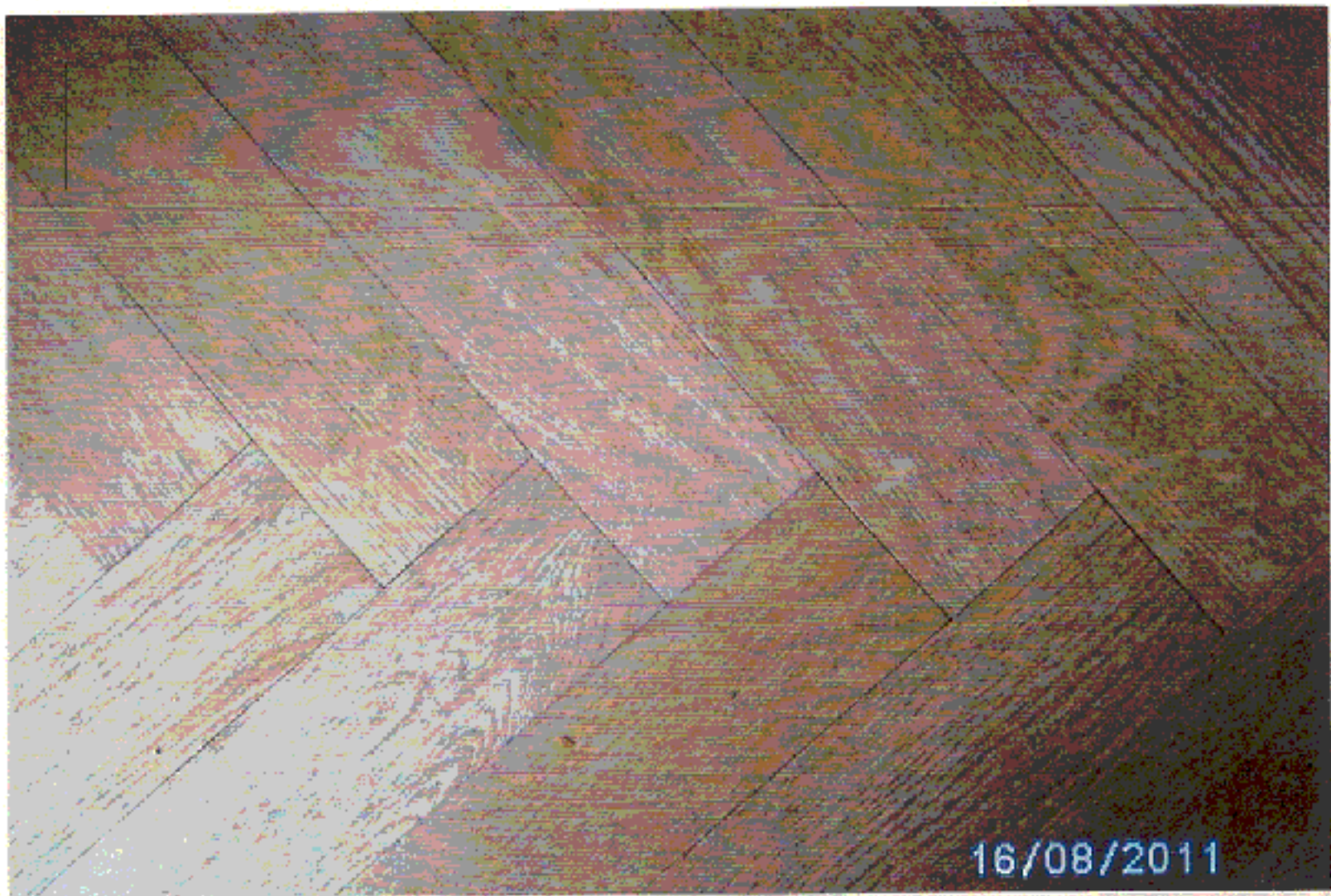
Bild 3 Allgemeines Aussehen und Zustand des Parkettbodens im Wohnzimmer mit dem hier üblichen Bild der Parkettfugen mit Breiten kleiner 2 mm
