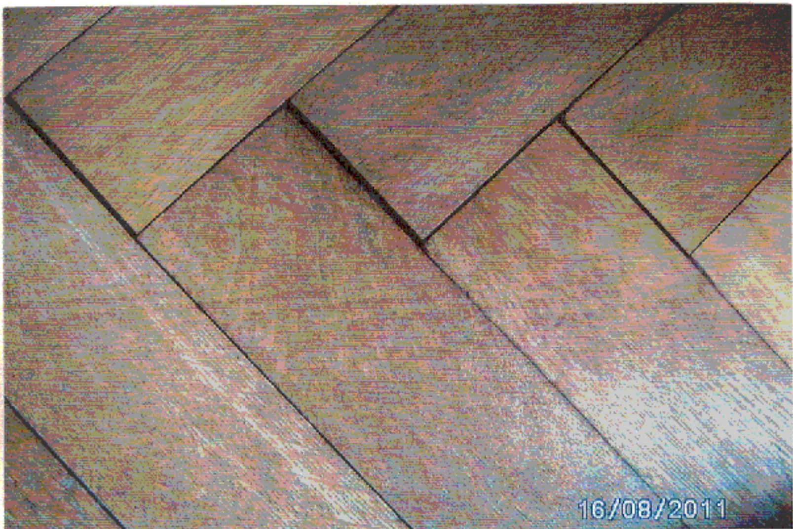
Bild 4 Beispiel für eine sehr selten auftretende sehr breite, aber sehr kurze Fuge (Breite 3,3 mm, Länge ca. 8 cm) am Kopfstoß der Parkettelemente im Wohnzimmer
