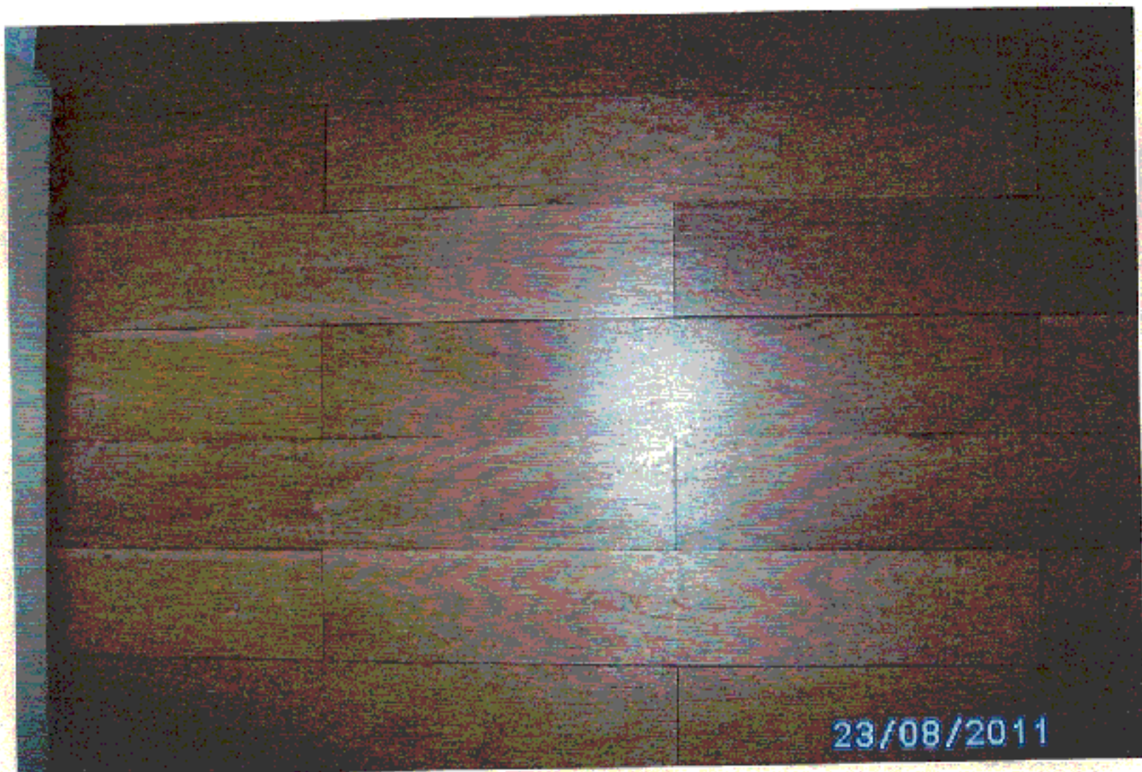
Bild 8 Allgemeines Aussehen und Zustand des Parkettbodens im Kinderzimmer mit dem hier üblichen Bild der Parkettfugen mit Breiten kleiner 2 mm
