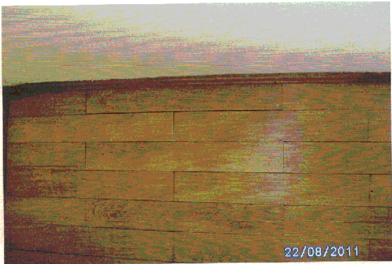
Bild 6 Beispiel für eine sehr selten auftretende Fuge mit einer Breite über 2 mm (Breite 2,8 mm, Länge ca. 0,5 m) am Längsstoß eines Parkettelementes im Schlafzimmer
