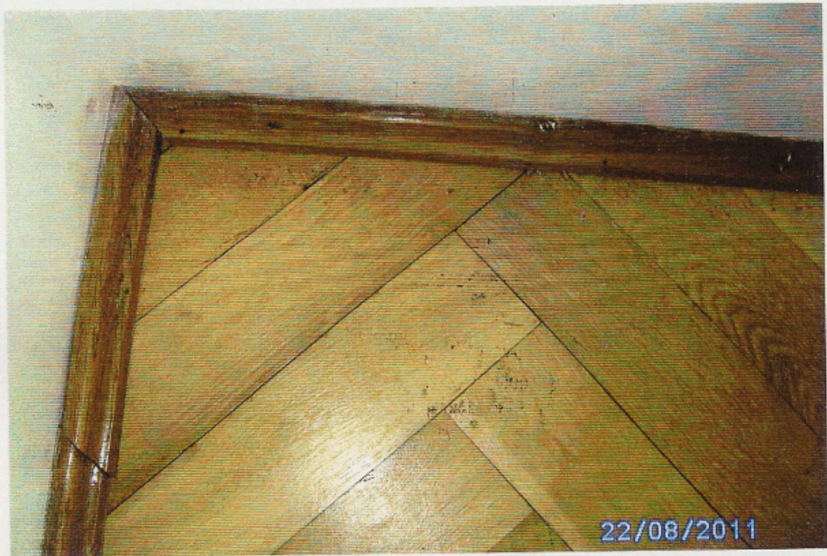
Bild 2 Ecke des Parkettbodens im Wohnzimmer rechts von der Türe mit den für das jetzige Gutachten wieder angebrachten Sockelleisten und Parkettteilen
