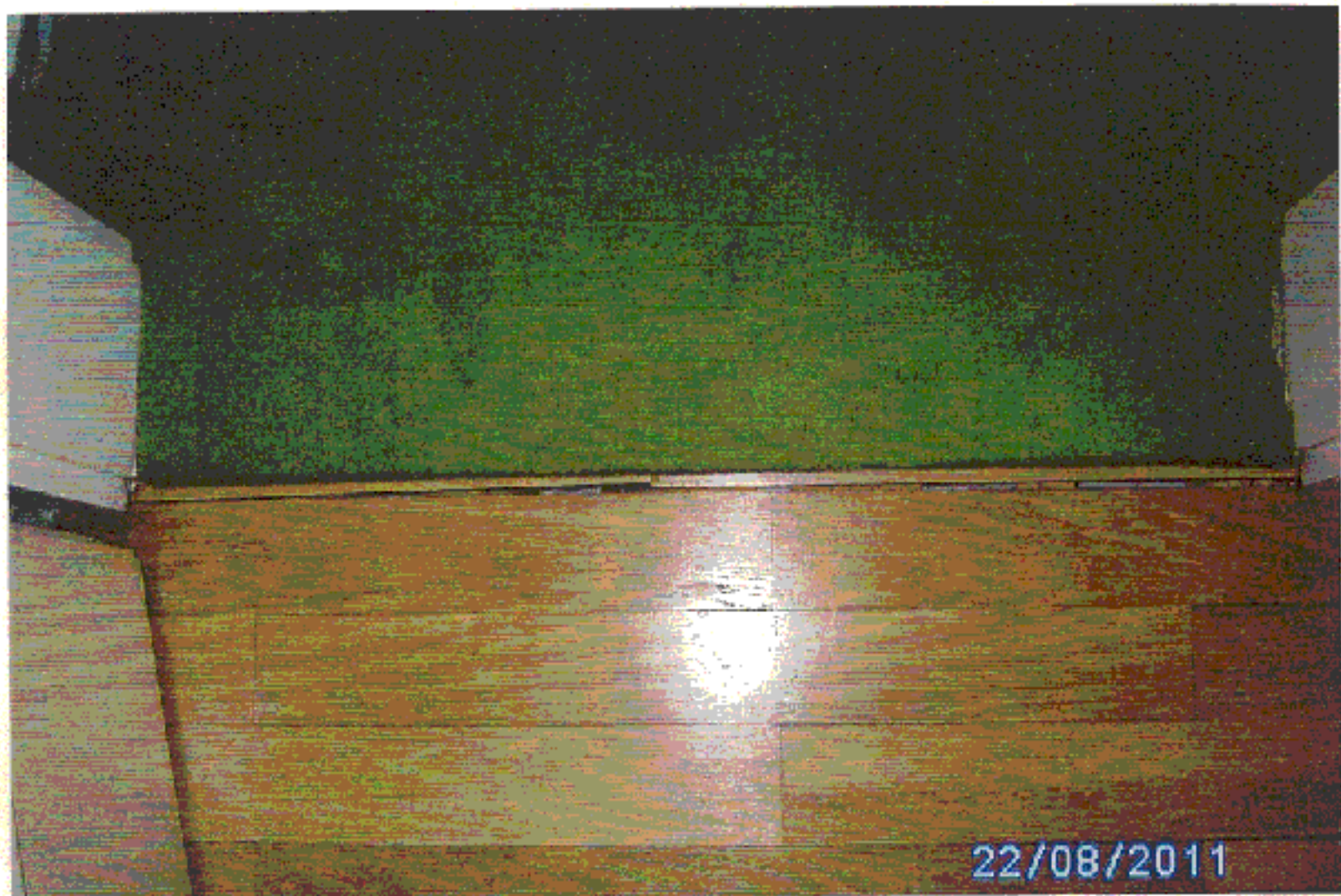
Bild 12 Breite Fuge (Breite ca. 1,0 bis 6,5 mm) an der Türschwelle vom Flur zum Gastzimmer durch unzureichenden Türanschluss
