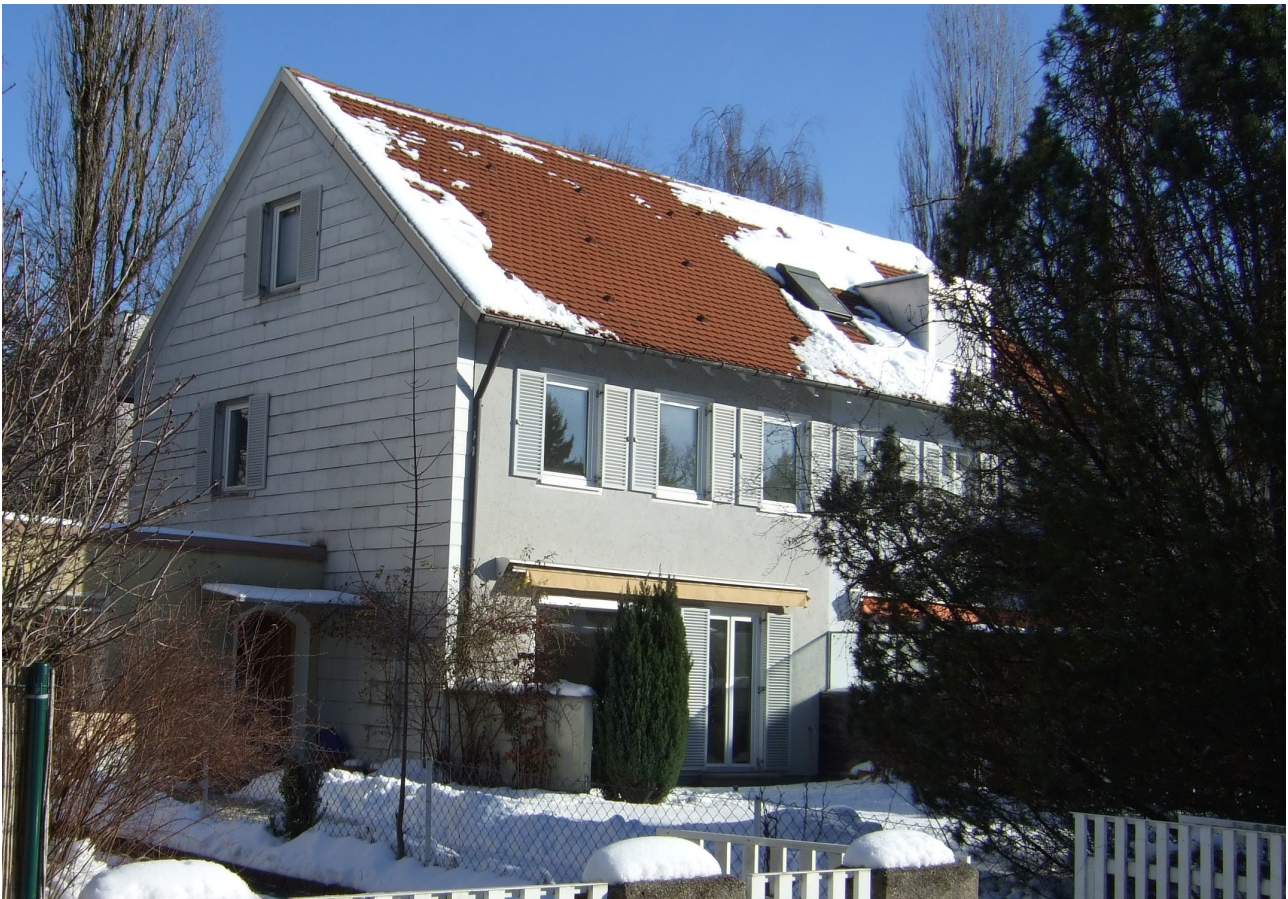
Ansicht des Hauses am 23.01.2013 (mit Eternitverkleidung, mit Terrassenwand)
