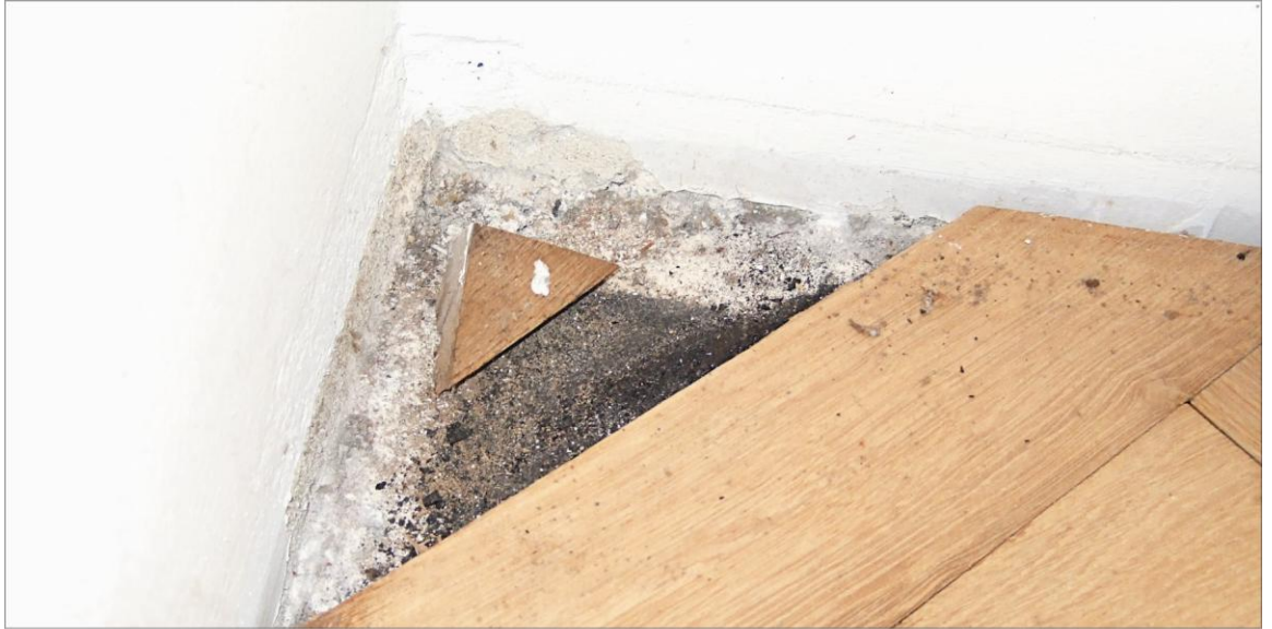
1. Foto: aufgestemmtes Parkett, Wohnzimmer
